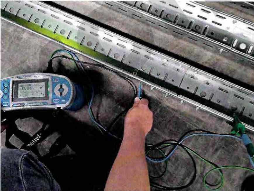
2. Соединение лотков УЛ(П) между собой с помощью соединителей универсальных СЛУ УЛ – значение замера 0,00
